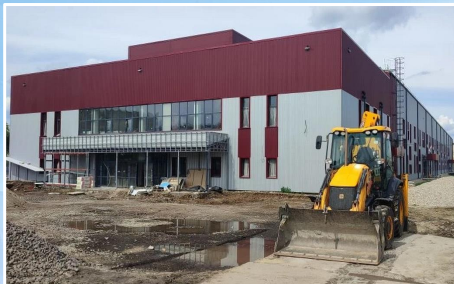
Строительство Легкоатлетического манежа
