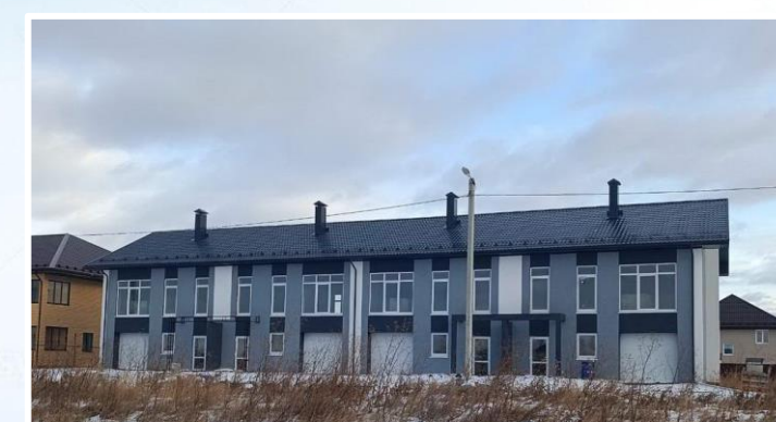
блокированный дом по ул. Каменская, 112
