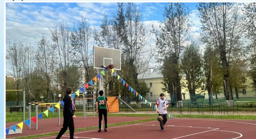
Устройство спортивной площадки Центра «Авангард (школа № 27)
