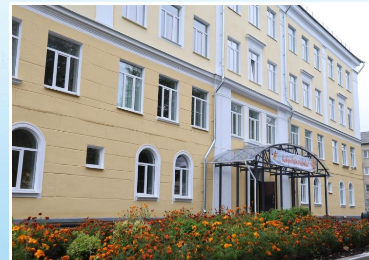
Капремонт Школы № 20 (1 этап)
