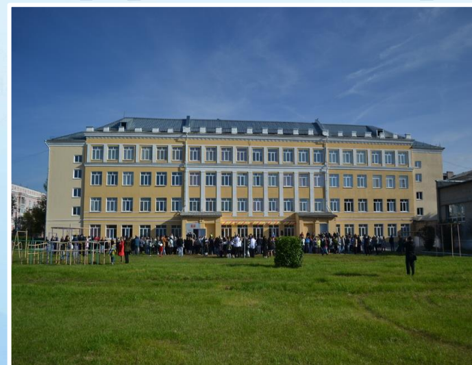
Капремонт Школы № 5 (2 этап)
