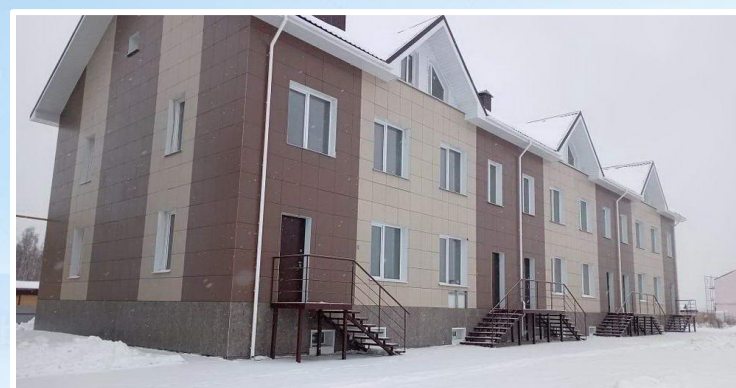
блокированный дом по ул. Маршала Жукова
