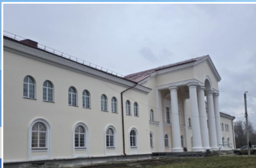
Капитальный ремонт здания ДКЦ
