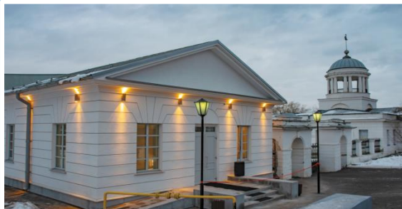
Реконструкция западного корпуса краеведческого музея (2021г.)
