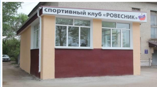
Ремонт спортклуба «Ровесник» (ул. Мичурина, 18) (2023г.)
