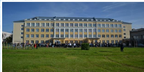
Ремонт Школы № 5 (2024-2025гг.)
