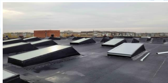
Капитальный ремонт кровли Средней школы № 60 (2022г.)
