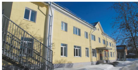
Ремонт Детского сада № 27 (2021г.)
