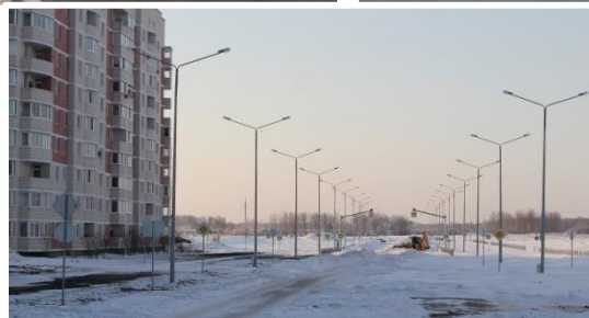
Строительство улицы Героев Отечества на участке от ул. Октябрьская до ул. Каменская (484 м) Ввод в эксплуатацию – февраль 2024 г.
