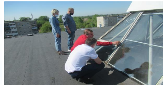
Капитальный ремонт кровли Средней школы № 37 (2021г.)
