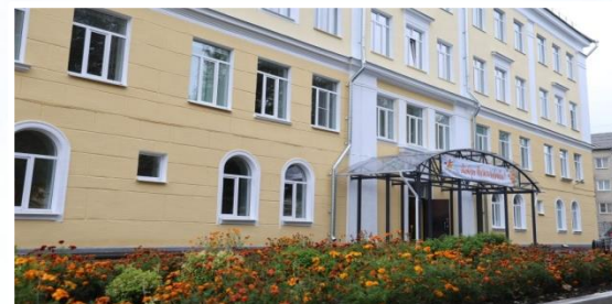
Ремонт Школы № 20 (1 этап) (2025г.)
