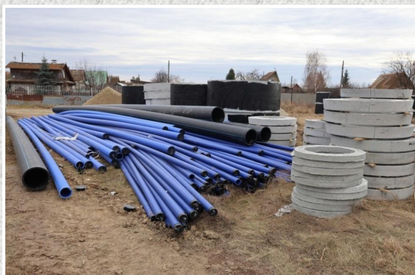
Начато строительство сетей водоснабжения в д. Кодинка и д. Малая Кодинка
