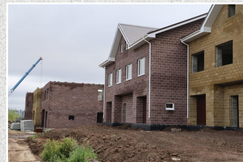
Дома ул.Маршала Жукова
