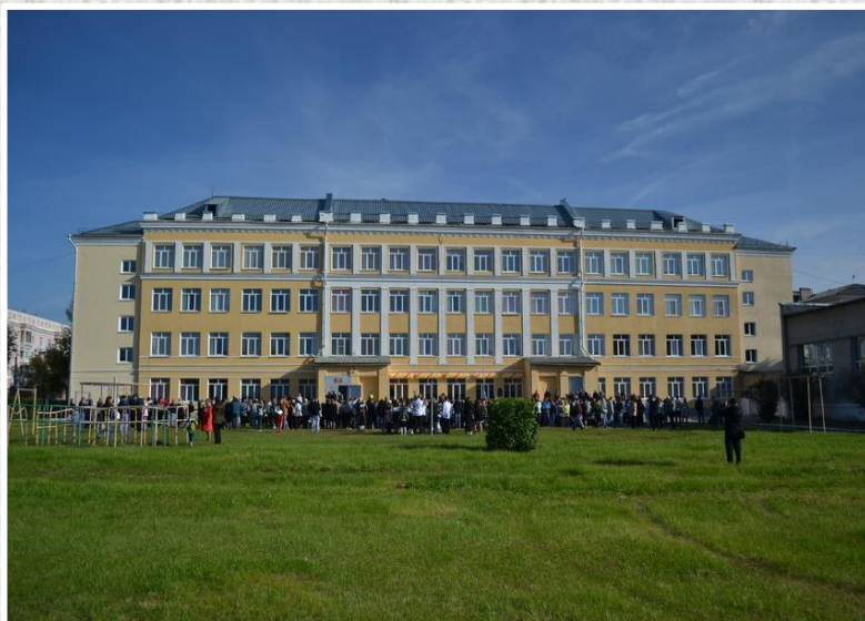
Ремонт Школы № 5 (2 этап)
