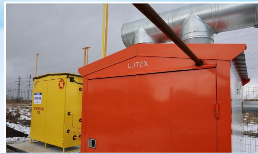
Газовая блочно-модульная котельная для школы № 14 (мощностью 0,3 МВт)
