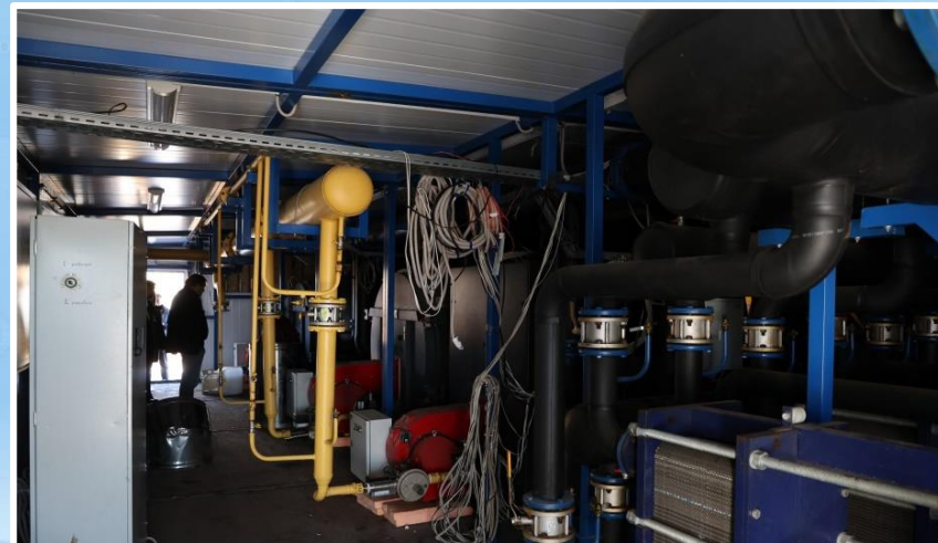
Газовая водогрейной котельной (ул. Революционная) (мощность 7,5 МВт)
