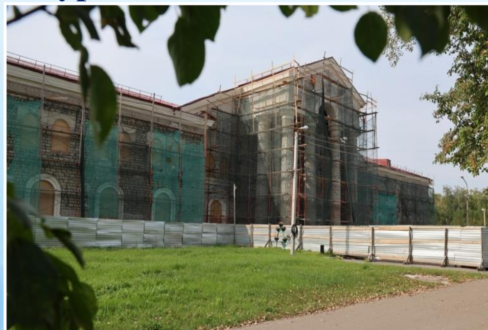
Капитальный ремонт здания ДКЦ
