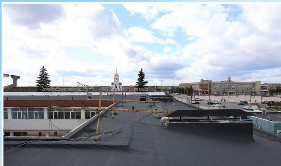
Ремонт кровли и фасадов ДК «Юность»
