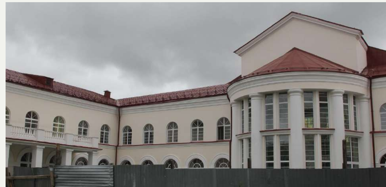
В Детском культурном центре в 2025 году планируем завершить наружные ремонтные работы
