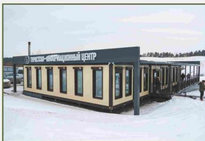
Установка и обустройство туристско-информационного центра на набережной реки Исеть
