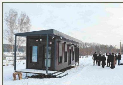
Установка павильона для торговли сувенирной продукцией с блоком общественных санузлов
