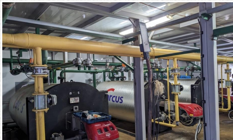
ООО «УК «ТЕПЛОКОМПЛЕКС» построена газовая блочно- модульная котельная (ул. Рябова) (мощность 2,4 МВт)
