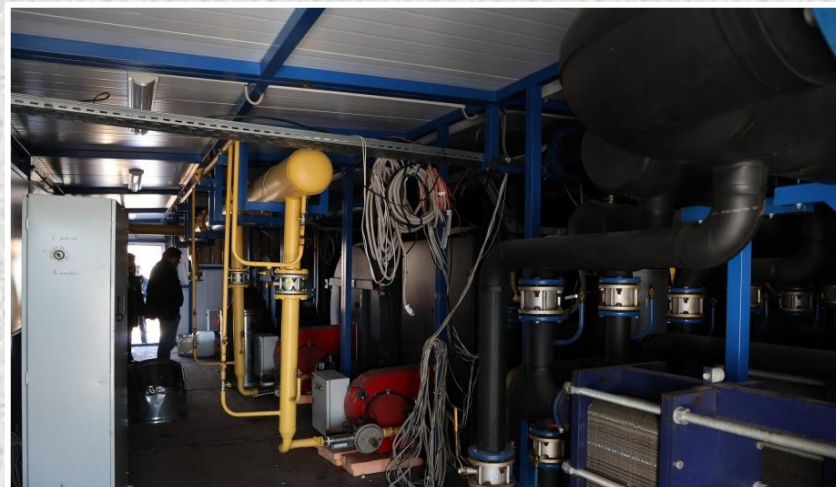
ООО «УК «ТЕПЛОКОМПЛЕКС» строительство газовой водогрейной котельной (ул. Революционная) (мощность 7,5 МВт)
