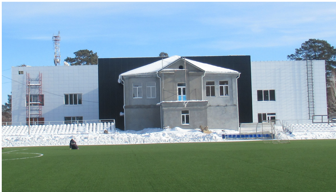
Реконструкция СК «Космос»
